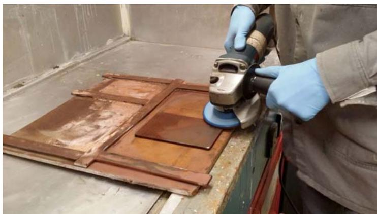
Figura 2. Tratamento mecânico de superfície com ferramenta rotativa até padrão St3 para todos os painéis.
